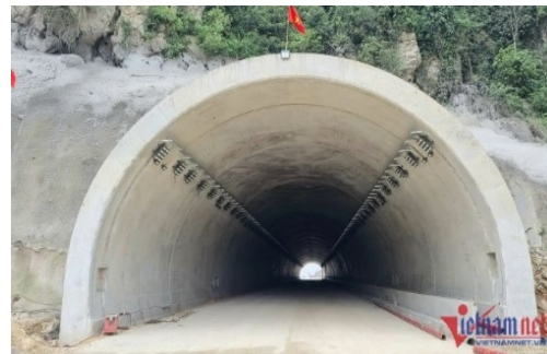
Ảnh chụp một ống hầm của hầm Trường Vinh.
